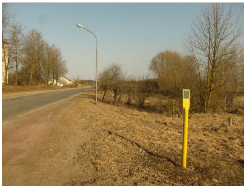
Рисунок 2.2 – Место размещения существующего газопровода высокого давления в районе пересечения улиц Коммунистическая и Солнечная
